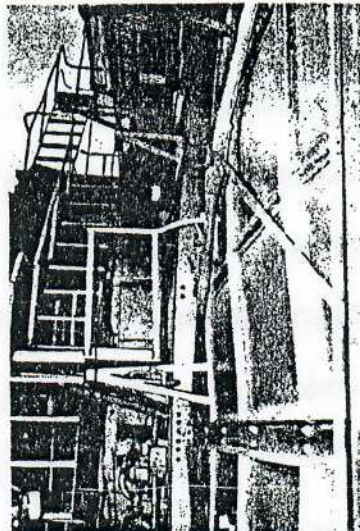
Foto 11 Outer casing sebelah kanan menonjol keluar
